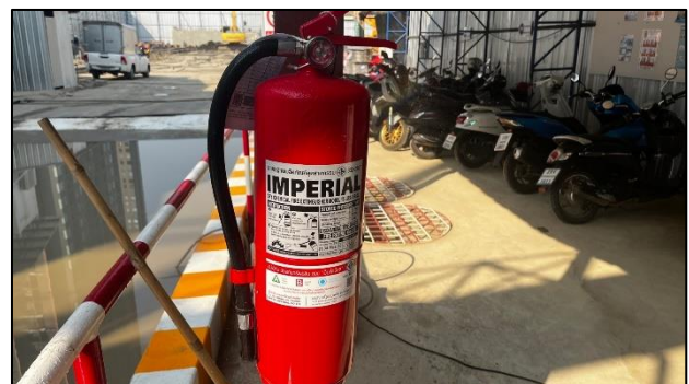
รูปที่ 23 ถังดับเพลิงเคมี พร้อมป้ายแนะนำการใช้ถังดับเพลิง
