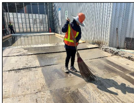
รูปที่ 8 ฉีดพรมน้ำบริเวณพื้นที่ก่อสร้าง ต่อไป พร้อมทั้งกวาดฝุ่นละออง และตะกอนภายหลังการฉีดพรมน้ำ
