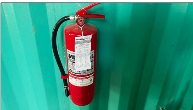
รูปที่ 23 ถังดับเพลิงเคมี พร้อมป้ายแนะนำการใช้ถังดับเพลิง
