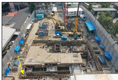
รูปที่ 14 Sheet Pile และทำค้ำยันเหล็ก (Bracing) โดยรอบแนวอาคารและระบบสาธารณูปโภคที่อยู่ใต้ดิน
