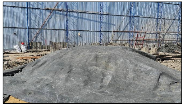
รูปที่ 5 กองวัสดุที่มีฝุ่นหรือเศษวัสดุที่เหลือใช้ ต้องปิดหรือคลุมด้วยผ้าใบให้มิดชิด
