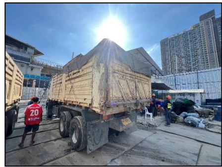
รูปที่ 5 กองวัสดุที่มีฝุ่นหรือเศษวัสดุที่เหลือใช้ ต้องปิดหรือคลุมด้วยผ้าใบให้มิดชิด
