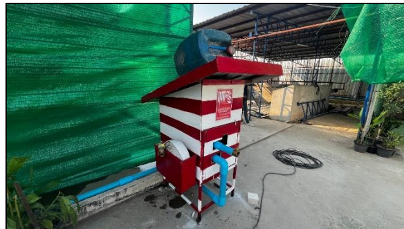
รูปที่ 33 หัวฉีดน้ำดับเพลิงมือถือแบบแห้ง และถังดับเพลิงเคมี
