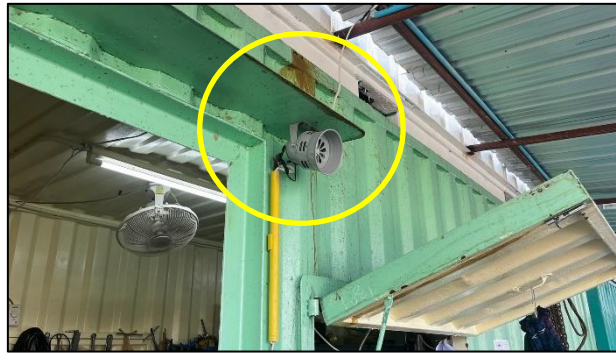
รูปที่ 30 ลำโพงกระจายเสียงแจ้งเหตุเตือนเพลิงไหม้
