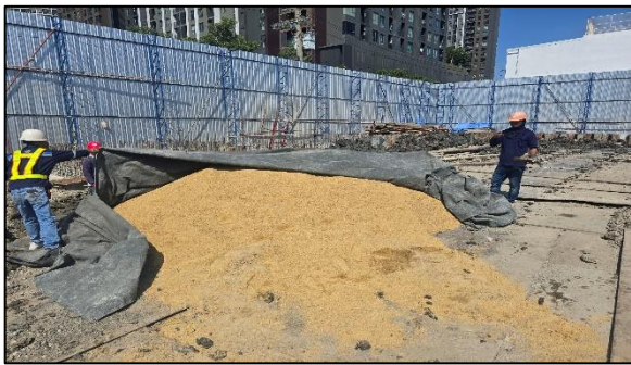
รูปที่ 5 กองวัสดุที่มีฝุ่นหรือเศษวัสดุที่เหลือใช้ ต้องปิดหรือคลุมด้วยผ้าใบให้มิดชิด
