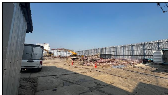
รูปที่ 11 แผ่นเหล็กอย่างหนาปูทั่วบริเวณภายในพื้นที่โครงการ
