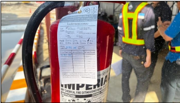
รูปที่ 23 ถังดับเพลิงเคมี พร้อมป้ายแนะนำการใช้ถังดับเพลิง (ต่อ)
