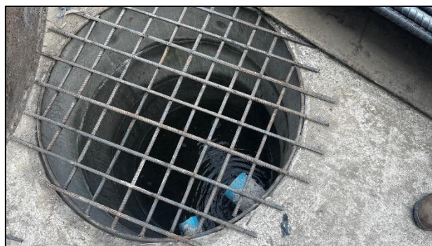
รูปที่ 19 บ่อพักน้ำ/บ่อดักขยะ
