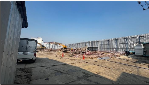
รูปที่ 4 รั้ว Metal Sheet ความสูง 6 เมตร โดยรอบโครงการ
