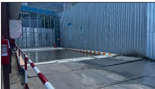
รูปที่ 7 จุดล้างล้อรถบรรทุกที่เข้า-ออกพื้นที่โครงการ
