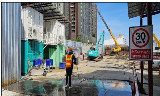
รูปที่ 7 จุดล้างล้อรถบรรทุกที่เข้า-ออกพื้นที่โครงการ (ต่อ)
